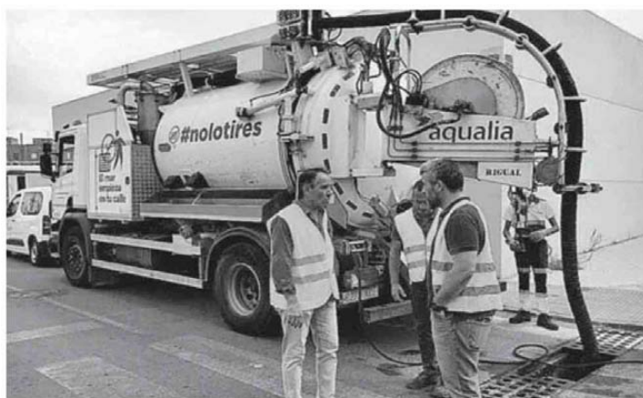
Visita del concejal de Agua a los trabajos de limpieza en marcha. LA VOZ
